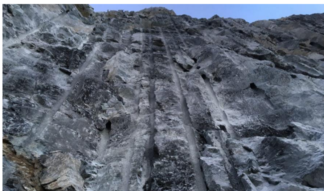
Figur 4: Tradisjonell kontursprengning til venstre og sømboring til høyre.
