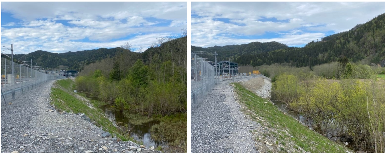
Figur 18 Adkomstveg til nytt verksted er bygd med bred skulder på utsiden av sikringsgjerdet for å ivareta turvegtrase. Flomskog vises til høyre for vegfyllingen.
