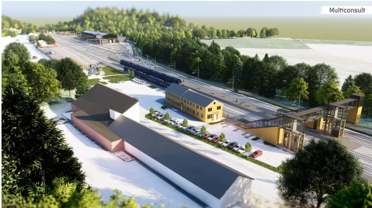
Figur 14 Planlagt utbygging med ny overgangsbru, plattformer og nytt spor sett fra sørvest.
