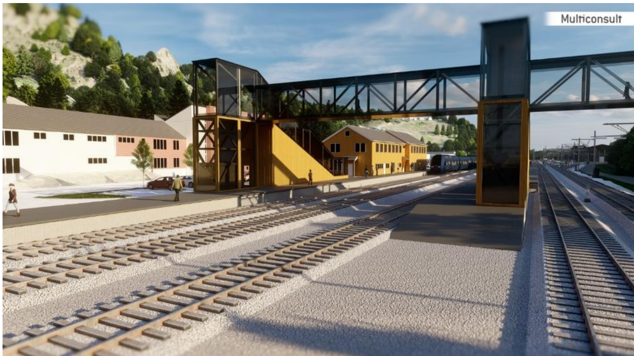
Figur 20 Overgangsbrua sett fra sør.
