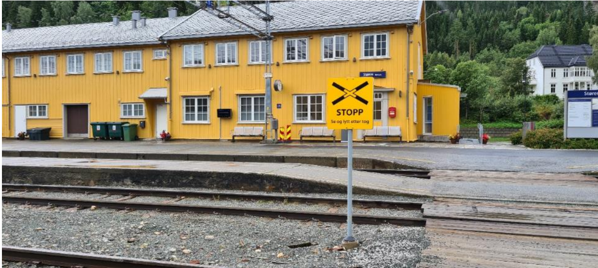
Figur 12 Støren stasjonsbygning. Foto: Multiconsult.
