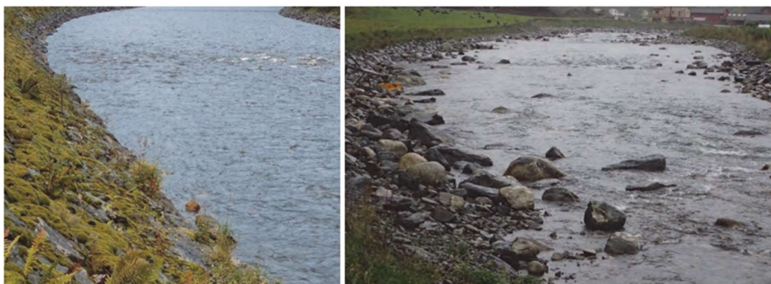
To måter å erosjonssikre en elv. Til venstre konvensjonell kanalisering med glatt plastring. Til høyre tilbakesatt erosjonssikring med mer naturtypiske bredder. Begge er hydraulisk tilstrekkelig dimensjonert, men høyre eksempel gir mer skjul for fisk og bedre ungfiskhabitat.
